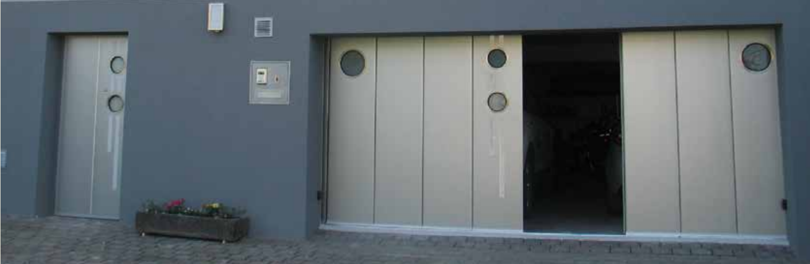
В двери можно расположить сэндвич-панели не только горизонтально, но и вертикально
